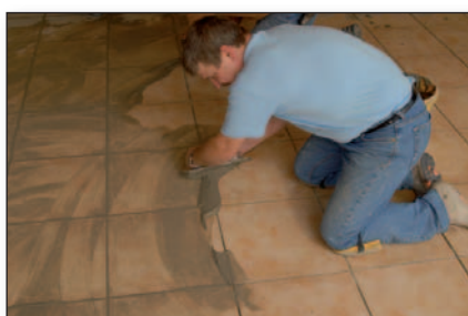
11. Verfugen mit PCI Fugenmaterial.
