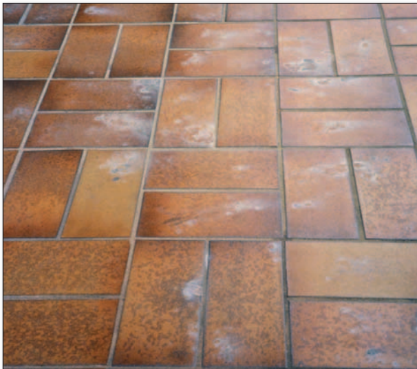
Altuntergründe können bei ausreichender Anschlusshöhe zu Türen ggf. liegen bleiben, der Rückbau entfällt.
