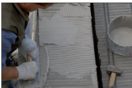
4. FERMACELL Epoxi-Kleber mit 6 bis 8 mm Zahnkelle auf Powerpanel SE Plattenkanten auftragen
