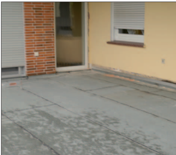
Typische Baustellensituation, Bitumenbahn ist verlegt, es stehen nur geringe Anschlusshöhen zur Verfügung.
