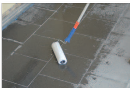
8. FERMACELL SE Platten werden mit PCI Gisogrund grundiert.
