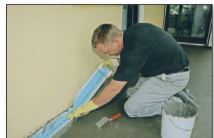
6. Einarbeitung des Spezial-Dichtband PCI Pecitape 120 oder PCI Pecitape WS.
