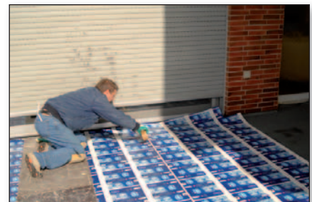
3. Trennlage (Tretapackfolie, Alternativen möglich) auf Schüttung.
