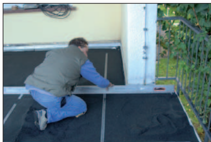
2. Gefällesituation herstellen, z.B. mit FERMACELL Gebundener Schüttung.
