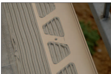
7. Bei Bedarf kann eine Balkonabschluss-schiene eingebaut werden.
