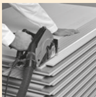
Absägen des überstehenden Falzes für die erste Verlegereihe
