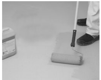
Vorbereitung: Boden grundieren und Randdämmstreifen verlegen
