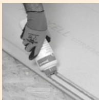
Verkleben der Falze mit FERMACELL Estrich-Kleber
