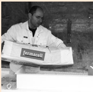
Ganzen Sack im Betonmischer anmischen, 8–10 Liter Wasser pro Sack kommen hinzu
