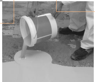
Boden-Nivelliermasse ausbringen und planeben nivellieren
