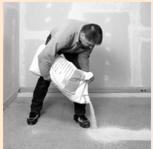
Anlegen der Dämme
