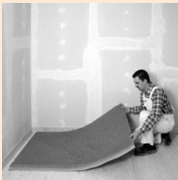
FERMACELL Estrich-Wabe verlegen
