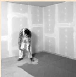
FERMACELL Wabenschüttung einbringen
