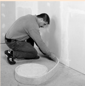
Aufbringen der Randdämmstreifen
