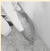
Randdämmstreifen verlegen und in den Ecken stumpf stoßen
