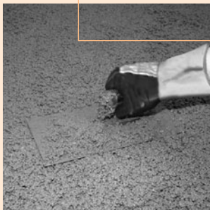
Mit der Glättkelle werden Unebenheiten egalisiert
