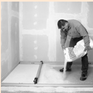
FERMACELL Ausgleichsschüttung einbringen
