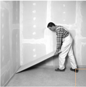
FERMACELL Estrich-Elemente verlegen
