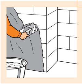
Bild 16: Bei Schornsteinwangen wird die Ansetzbinderschicht auf das Mauerwerk aufgezogen und die FERMACELL-Platte hineingedrückt
