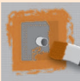
Abb. 4: Zur Abdichtung von Rohrdurchführungen die Wanddichtmanschette in die noch feuchte FERMACELL Flüssigfolie einbetten und direkt erneut überstreichen
