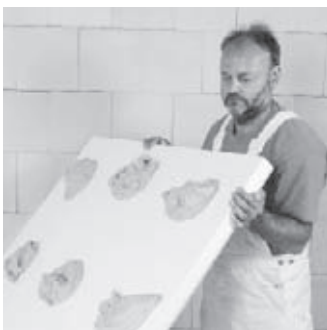
Bild 45: Die wärmedämmende FERMACELL Verbund-Platte. Im Format 150 x 100 cm. In zwei verschiedenen Dicken lieferbar.
