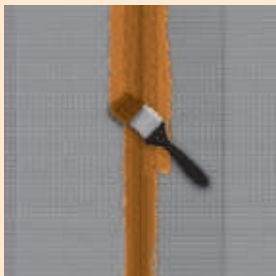
Abb. 2: FERMACELL Dichtband in die zuvor aufgetragene, noch feuchte FERMACELL Flüssigfolie drücken und direkt mit Flüssigfolie überstreichen
