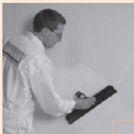
Bild 39: Flächenspachtelung mit FERMACELL Feinspachtel und mit FERMACELL Gips-Flächenspachtel
