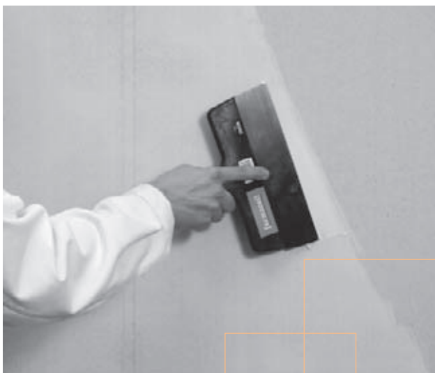
Bild 40: Flächenspachtelung von FERMACELL Gipsfaser-Platten
