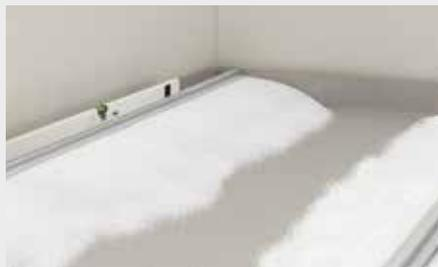
Zwei parallele Dämme in der vorgesehenen Höhe aufschütten. Auf die Dämme dann die Abziehlatten (z. B. **fermacell** Abziehlatten-Set) auflegen.
