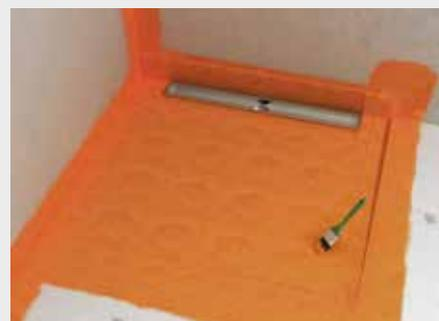
Anschließend den Gefällebereich vollflächig abdichten z. B. mit dem **fermacell** Abdichtungssystem.
