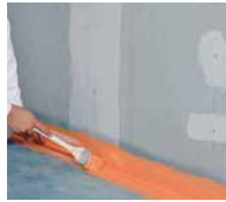
Dichtband direkt nach dem Eindrücken mit **fermacell** Flüssigfolie überstreichen.
