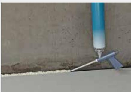
Ist die Fläche fertig verlegt, sollten offene Rand- und Anschlussfugen geschlossen werden, z. B. mit Montageschaum, da sonst Wärmebrücken entstehen könnten.
