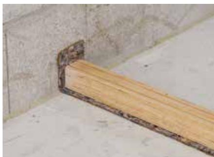
Auf das Holzständerwerk für Decke, Boden und Seitenwände (z. B. das **fermacell** Holzständerwerk 3D) 50 mm breite Randdämmstreifen aufkleben.
