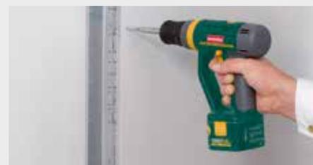
Die Platten mit **fermacell** Powerpanel H<sub>2</sub>O Schnellbauschrauben im Abstand von 20 cm auf der Unterkonstruktion befestigen.
