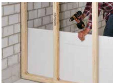
**fermacell** Gipsfaser-Platten mit der **fermacell** Schnellbauschraube 3,9 x 30 mm (Abstand max. 250 mm) verschrauben. Senkrechte Plattenstöße erfolgen immer auf dem Holzständerwerk.
