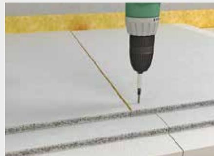
Elemente mit beigefügten Schrauben miteinander verschrauben. Anschließend auf der umliegenden Fläche **fermacell** Powerpanel TE auf geeignetem Dämmstoff bzw. Fußbodenheizung verlegen.
