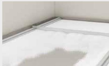
Nach dem Abziehen werden die Abziehlatten entfernt und die **fermacell** Estrich-Elemente verlegt. Zum Schutz der abgezogenen Schüttung sind Laufinseln zu verwenden, z. B. **fermacell** Gipsfaser-Platten > 500 x 500 mm.
