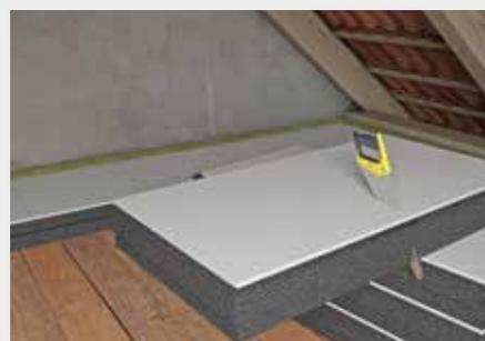
Das jeweilige Endstück der Reihe sägen Sie einfach mit einem Fuchsschwanz auf die passende Länge. Das Reststück ist dann das erste Element für die nächste Reihe.
