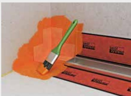
Anschluss an angrenzende Bauteile abdichten z. B. mit **fermacell** Dichtband/**fermacell** Dichtecken.
