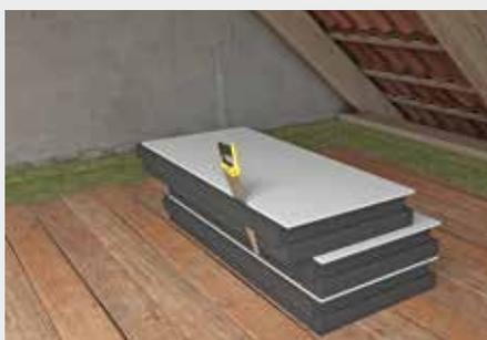
Die Verlegung erfolgt von rechts nach links im schleppenden Verband. Für die 1. Verlegereihe wird die überstehende Feder längsseitig abgesägt.
