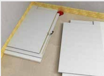
**fermacell** Powerpanel TE Gefälle-Elemente ausrichten und beigefügten Estrich-Kleber auf den Stufenfalz auftragen.
