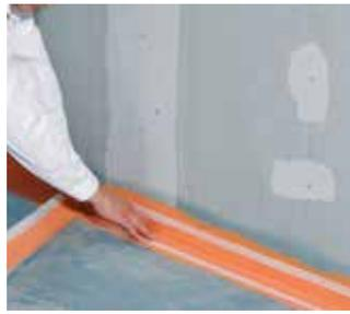
**fermacell** Flüssigfolie in die Ecke auftragen. In die feuchte Flüssigfolie das **fermacell** Dichtband eindrücken.
