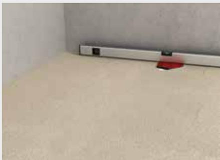
Ablauftopf positionieren, anschließen und Boden auf Höhe des Ablaufs ausgleichen z. B. mit **fermacell** gebundene Schüttung.
