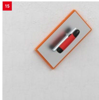
Abfilzen des fermacell™ Leichtmörtels HD
