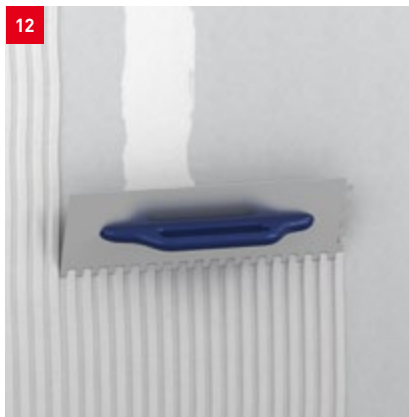
Aufbringen des fermacell™ Leichtmörtels in Bahnbreiten des Armierungsgewebes
