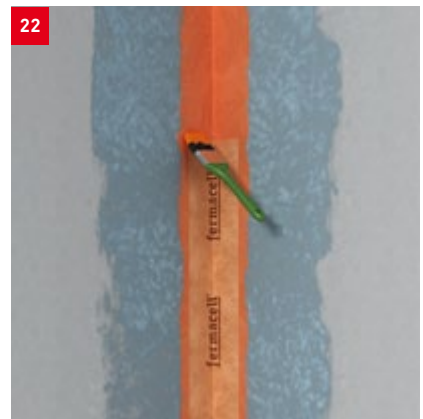
Erneut mit fermacell™ Flüssigfolie überstreichen
