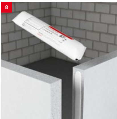
Verklebung mit Aestuver™ Brandschutzkleber 1300 – Eckverklebung
