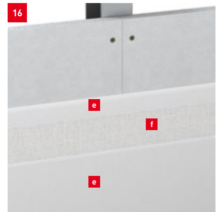
Systemaufbau der Beschichtung mit Spachteltechnik
