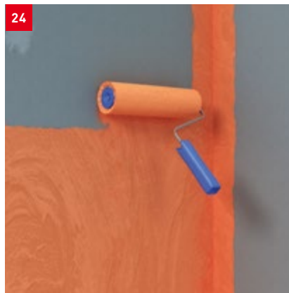
fermacell™ Flüssigfolie mit der Rolle 2×vollflächig auftragen
