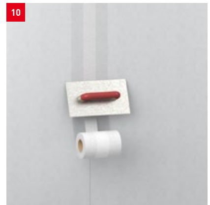
Aufbringen des fermacell™ Armierungsbandes HD
