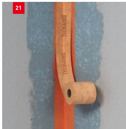
fermacell™ Dichtband in die noch feuchte fermacell™ Flüssigfolie drücken
