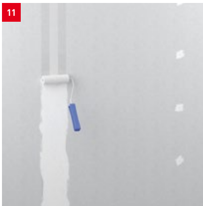
Aufbringen des fermacell™ Armierungsklebers HD
