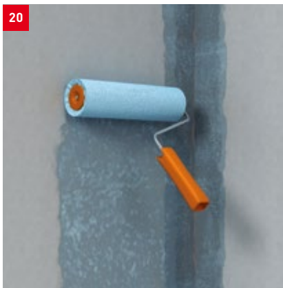
Aufbringen des fermacell™ Tiefengrunds
