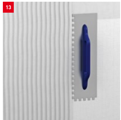
Verlegung des fermacell™ Armierungsgewebes HD in das Mörtelbett
