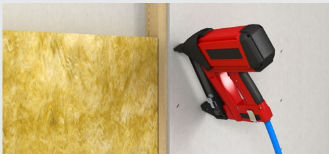
Klammern auf Holz-Unterkonstruktion
