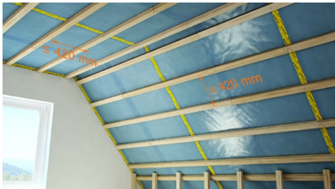
Achsabstände Unterkonstruktion bei Decken und Dachschrägen
