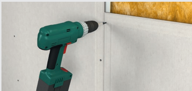
Schrauben auf Stahl-Unterkonstruktion
