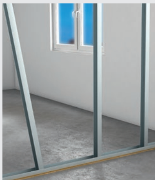
Montage der CW-Ständerprofile
