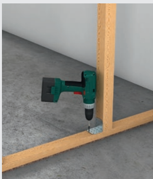
Montage der Holzständer mit Stiftnagel oder Stahlwinkel
