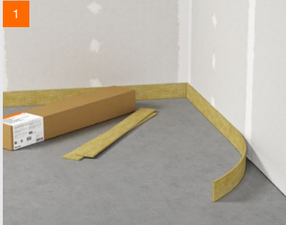
Anbringen der Randdämmstreifen
