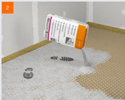
fermacell™ Wabenschüttung einbringen
