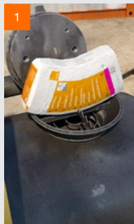
Mischungsverhältnis: 6 Säcke fermacell™ Wabenschüttung + 1 Gebinde fermacell™ Schüttungsbinder
