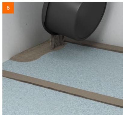
6 Anschließend wird die fermacell™ Gebundene Schüttung T zwischen den Dämmen ausgebracht ...
