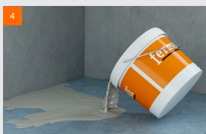
Boden-Nivelliermasse ausbringen und planeben nivellieren
