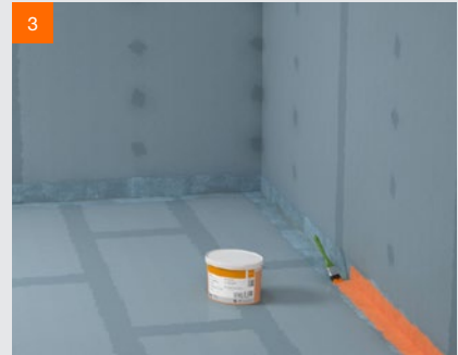
3 fermacell™ Flüssigfolie in der Ecke auftragen
