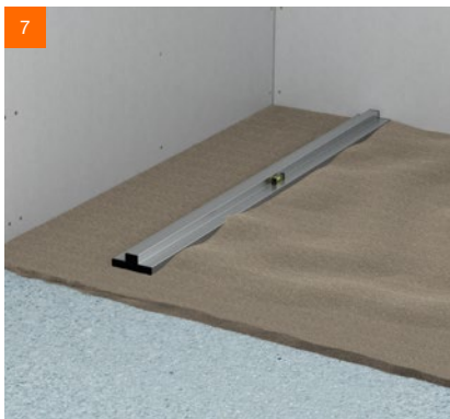
7 ... und auf den leicht verdichteten Dämmen abgezogen
