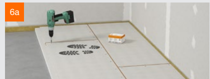
3 Verlegen der fermacell® Estrichelemente
