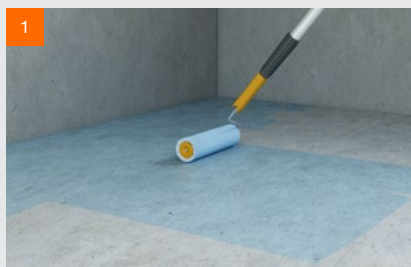
Vorbereitung: Boden grundieren
