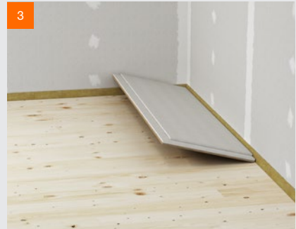
3 Verlegen der fermacell® Estrichelemente
