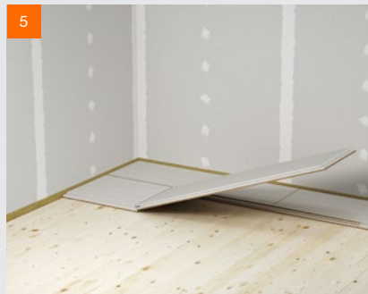
5 Verkleben der Elemente mit vollständig gefüllten Fugen
