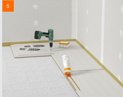
Verlegen der fermacell® Estrichelemente auf fermacell™ Ausgleichsschüttung
