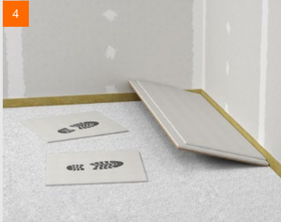
Verlegen der fermacell® Estrichelemente auf fermacell™ Ausgleichsschüttung
