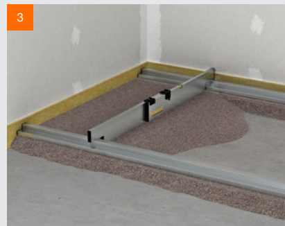
fermacell™ Gebundene Splittschüttung abziehen
