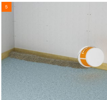
5 Anschließend hat die fermacell™ Gebundene Schüttung eine erdfeuchte Konsistenz. Der erste Damm wird angelegt
