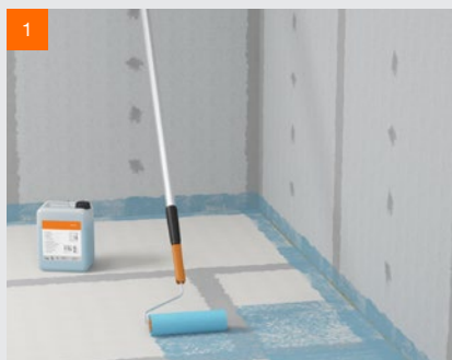
fermacell™ Tiefengrund unverdünnt im angrenzenden Wandbereich und Bodenbereich per Rolle auftragen
