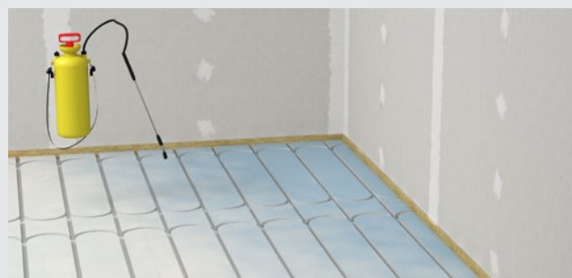
Grundieren der fermacell® Therm25™ Elemente mit fermacell™ Tiefengrund (unverdünnt)
