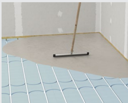
Ausgießen der Therm25™ Elemente mit fermacell™ Ansetzbinder
