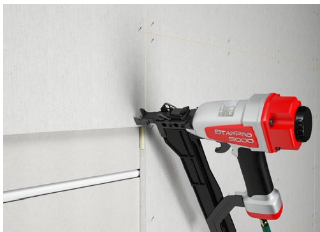
Befestigung zusätzliche Lage fermacell® Gipsfaserplatte oder Powerpanel H 2 O inkl. Fugenausbildung
