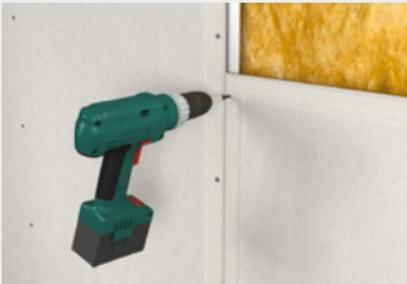
**fermacell® Gipsfaser-Platten können bis an die Kante (ca. 10 mm) geschraubt und geklammert werden – ohne auszubrechen.**
