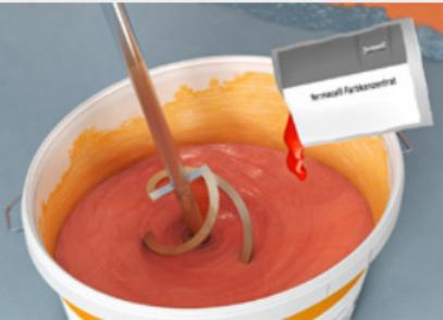
Abb. 7: 2. Auftrag: Farbkonzentrat zur Restmenge der Flüssigfolie geben und homogen einrühren. Eingefärbte Flüssigfolie satt auftragen. Weitere Informationen sind im Produktdatenblatt zu finden.
