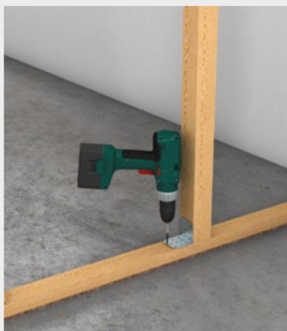
Montage der Holzständer mit Stiftnagel oder Stahlwinkel
