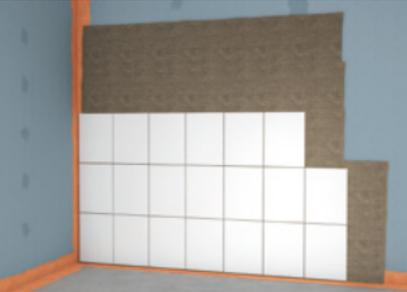
Abb. 5: Sicherstellung der Abdichtung für die Wassereinwirkungsklasse W0-I. Verfliesung mit fermacell™ Flexkleber im Dünnbettverfahren
