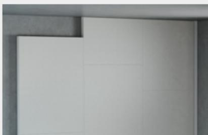
Die Platte leicht an die Wand drücken und durch Klopfen mit dem Richtscheit ausrichten.
