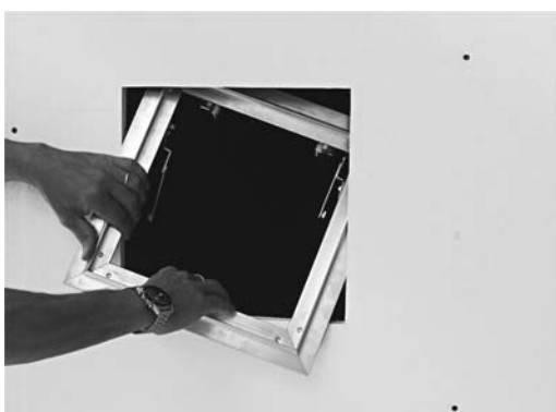
2. Klappendeckel aushängen, Rahmen diagonal durch den Ausschnitt führen und auflegen
