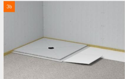
Variante B: Um auf die Höhe des Stufenfalzes vom Duschelement zu kommen, wird über die Fläche 10 mm dicker Dämmstoff (EPS DEO 150) verlegt
