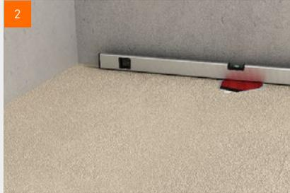
2 Ein fermacell™ gebundenes Schüttungsprodukt nach Verpackungsangaben mischen und auf Höhe der Oberkante des Ablauftopfes (ca. 95 mm) ausnivellieren sowie auf Ebenheit überprüfen.
