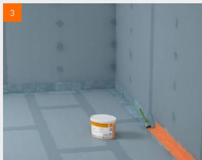
3 fermacell™ Flüssigfolie in der Ecke auftragen
