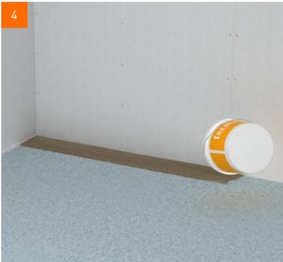
4 Anschließend hat die Gebundene Schüttung T eine erdfeuchte Konsistenz. Der erste Damm wird angelegt
