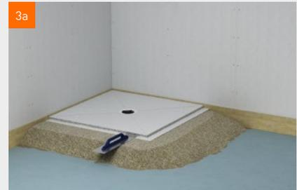
Variante A: Um das Duschelement wird in Höhe des überstehenden Falzes ein ca. 200 mm breiter Damm geschüttet – als Auflage für das Abziehen der restlichen Fläche
