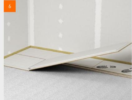
Verlegen der fermacell® Estrich-Elemente auf fermacell™ Ausgleichsschüttung
