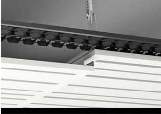
**fermacell** ACOUSTIC small board ist fertig oberflächenbeschichtet und wird durch ein Klemm-System nur noch in ein systemzugehöriges, abgehängtes Tragprofilssystem eingeclipst.
