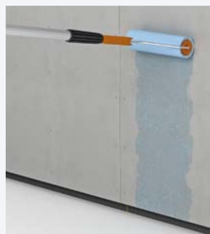
Vorbehandlung der fermacell® Powerpanel H<sub>2</sub>O Platten mit dem fermacell™ Tiefengrund
