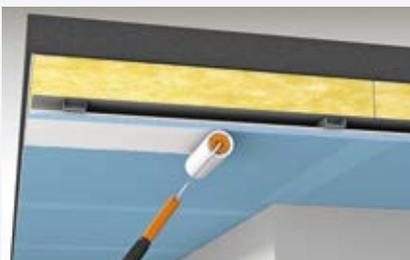
KEIM Soldalit wird als Einbettschicht für das nachfolgende fermacell™ Powerpanel Malervlies satt vorgelegt. Die Farbe darf nicht angetrocknet sein, ansonsten haftet das Vlies nicht auf der Platte bzw. in der Farbe und es entstehen Hohlstellen.
